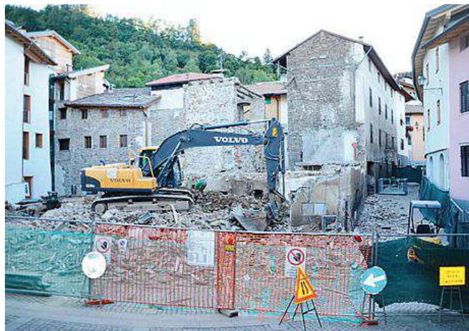
Praticamente terminata la demolizione di casa Sevegnani
